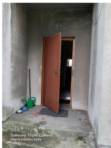
wejście do budynku
