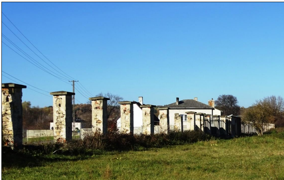
Fragment zachodniej części ogrodzenia
