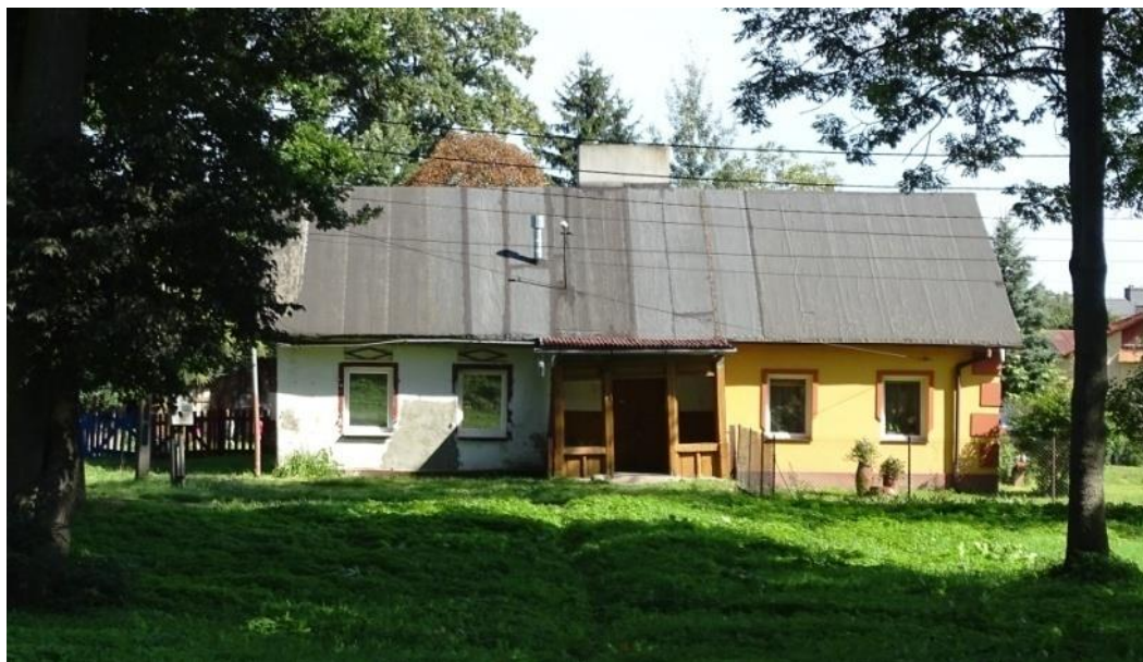
Dom – Nietulisko Duże 29 (widok na fasadę)
