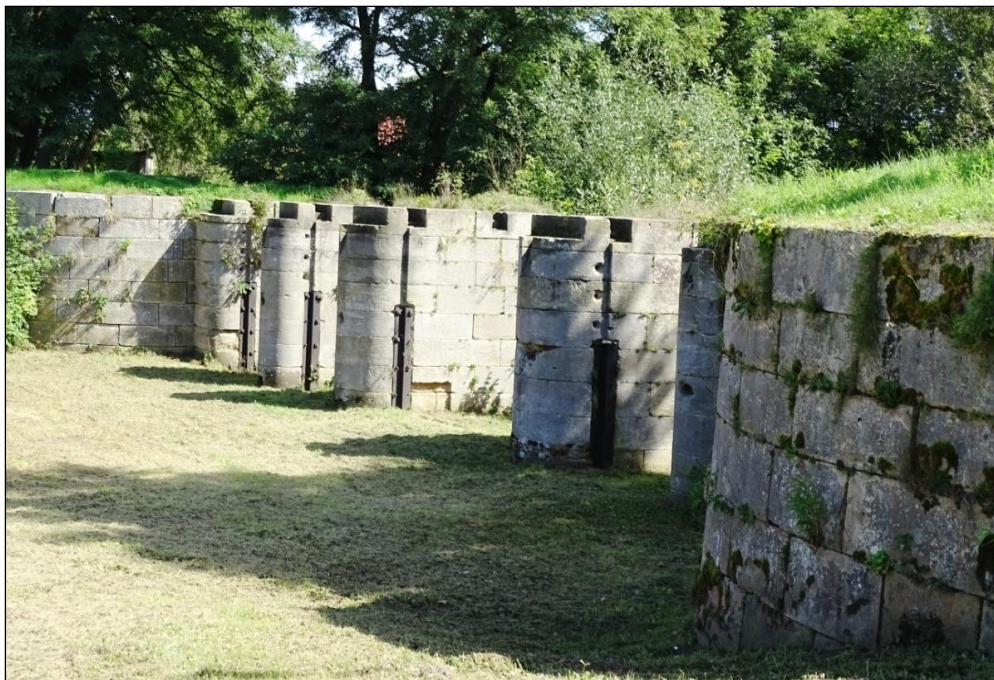
Widok jazu od wody górnej
