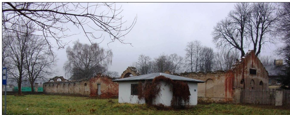
Widok na elewację tylną
