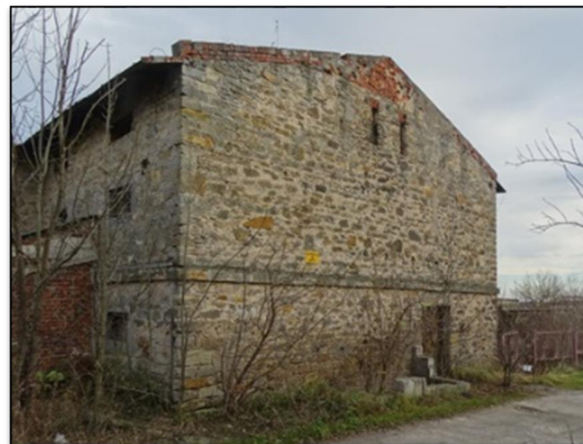
Elewacja szczytowa – południowa
