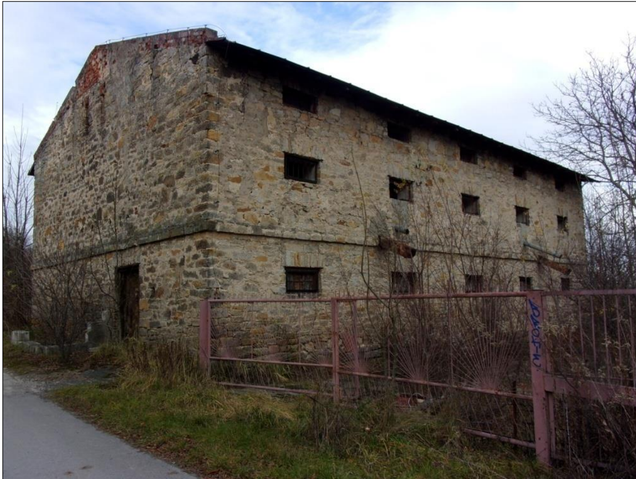
Widok na elewację: wschodnią i szczytową – południową
