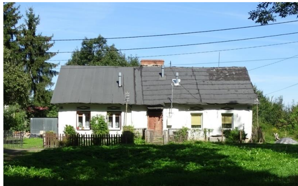
Dom – Nietulisko Duże 32 (widok na fasadę)
