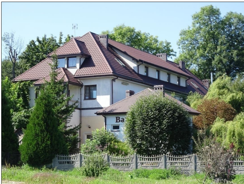
Widok na północną i wschodnią część dworu
