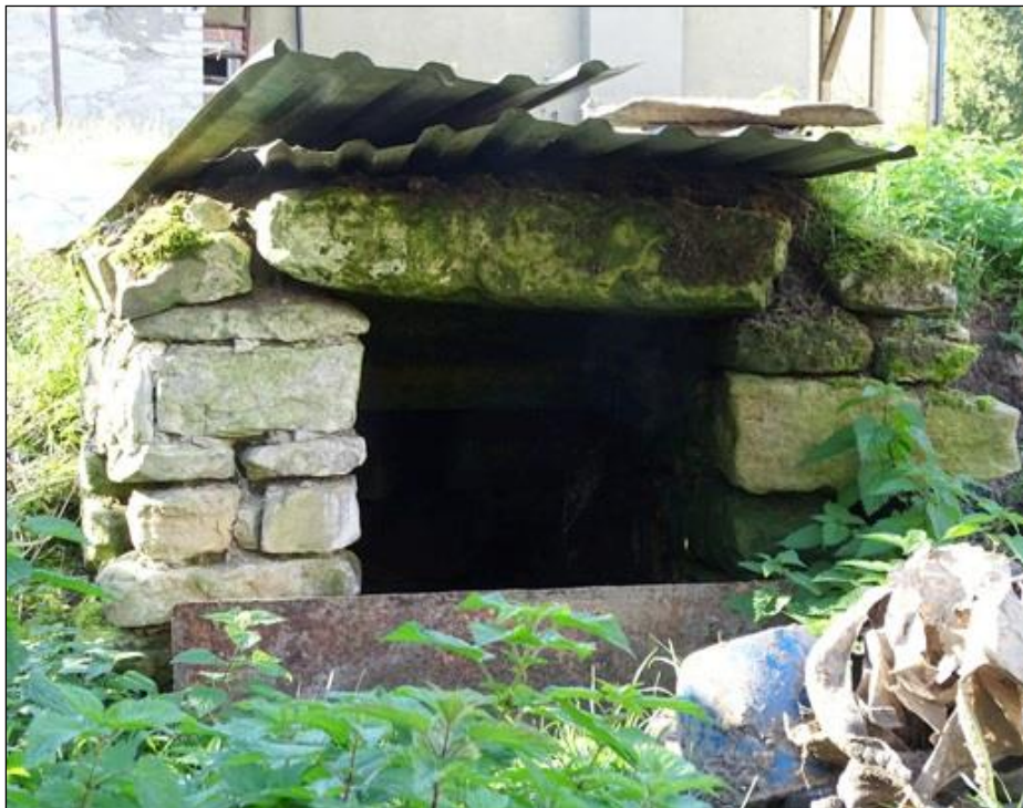
Wejście do piwnicy
