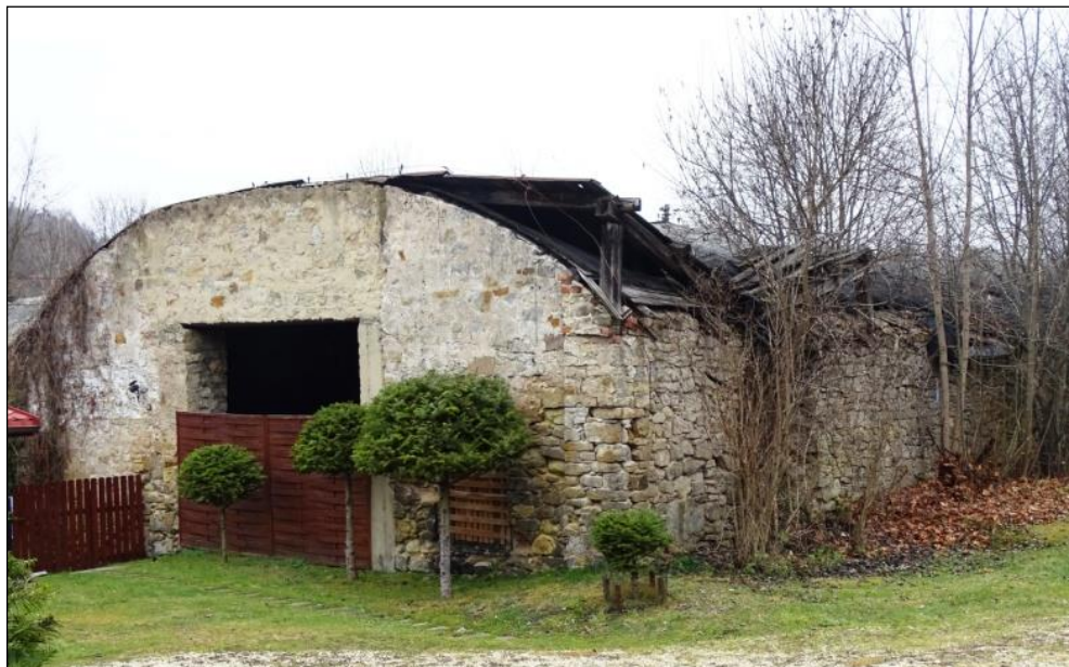
Warsztat kamieniarski zw. Wrocław – elewacje: południowa i frag. wschodniej
