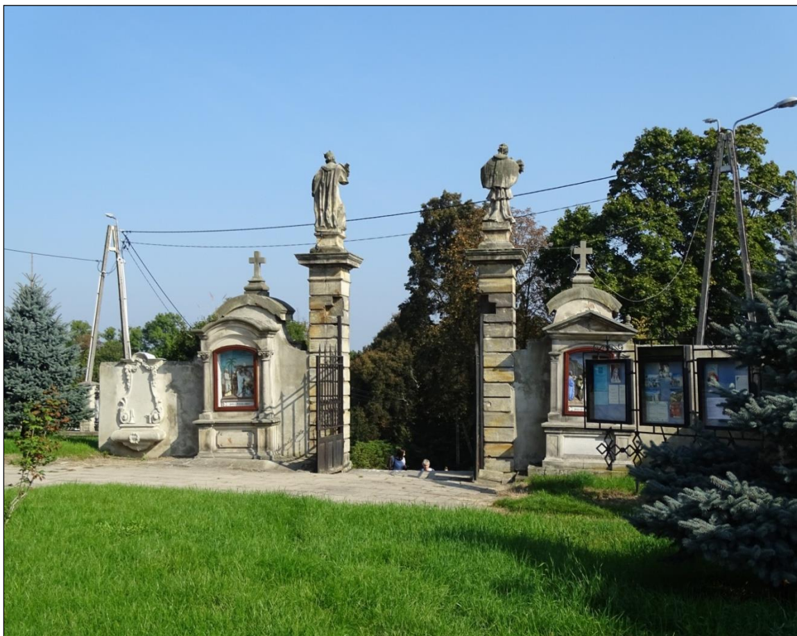
Fragment ogrodzenia z bramą główną – widok od strony cmentarza kościelnego
