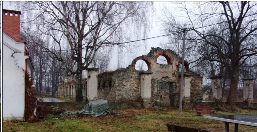
Widok na elewację szczytową – zachodnią; z boku widać fragment budynku kontrolnego II (wartowni)
