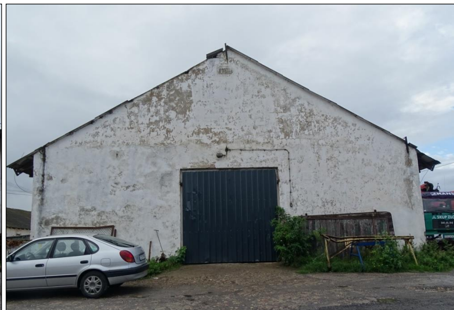
Obora z datą „1909” widniejącą w szczycie elewacji północnej
