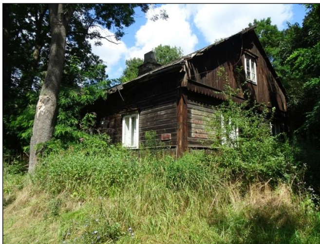
Fragment fasady i elewacji szczytowej
