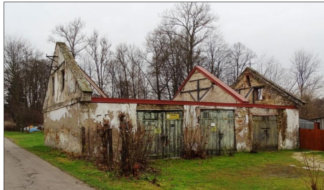
Warsztat kamieniarski (późniejsze garaże) – elewacje: północna i szczytowa – wschodnia
