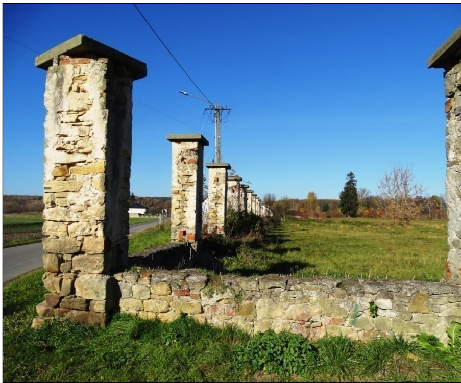
Południowo-zachodni fragment ogrodzenia
