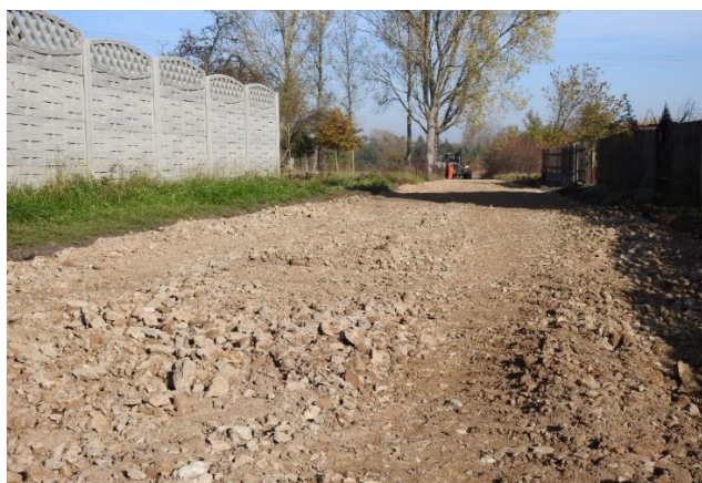
Remont ulicy Iłżeckiej w Kunowie.
