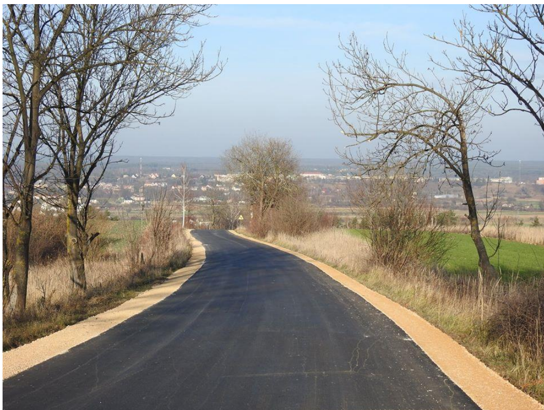
Droga powiatowa w miejscowości Bukowie po remoncie.
