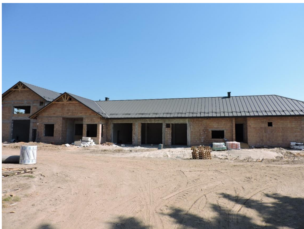
Oczyszczalnia ścieków w budowie.
