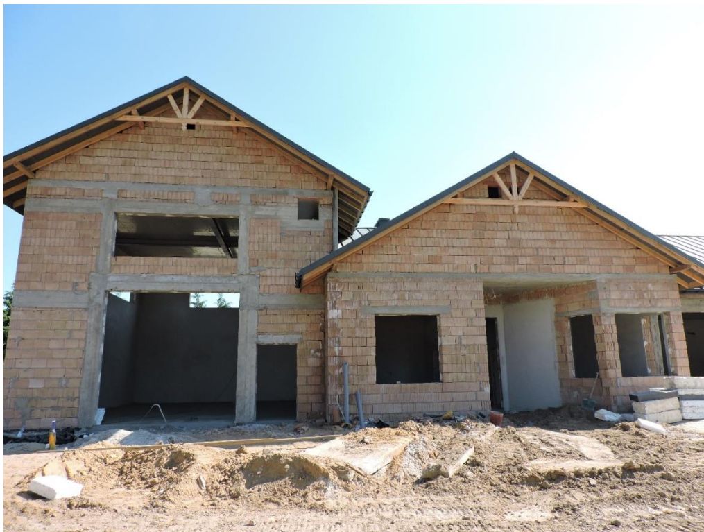
Oczyszczalnia ścieków w budowie.
