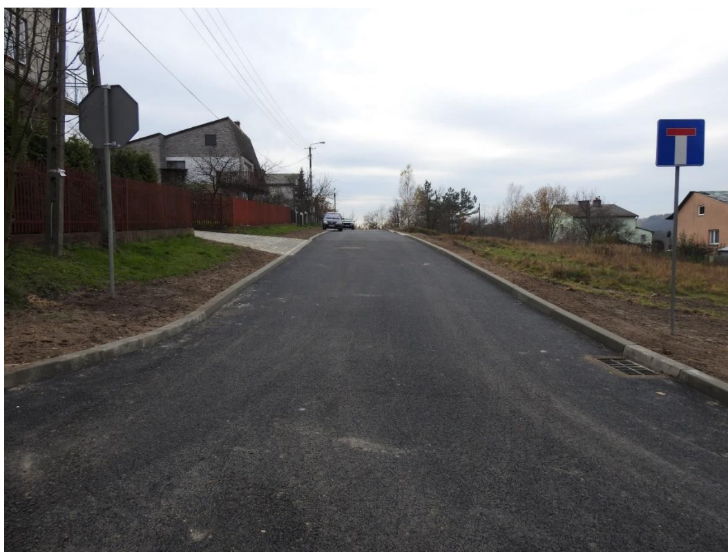
ul. Małachowska po remoncie.
