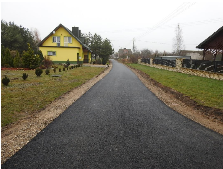
Wyremontowana ul. Hłzecka w Kunowie.
