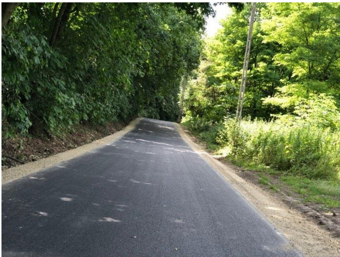
Droga powiatowa – ul. Kościelna po remoncie.
