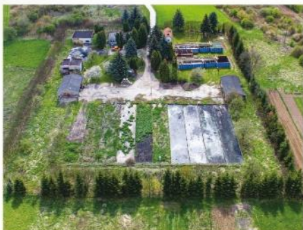
Oczyszczalnia w 2016 roku
