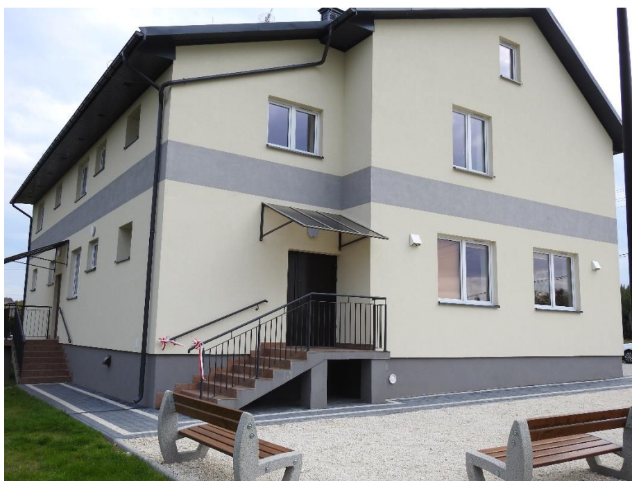
Budynek usługowo – mieszkalny ze świetlicą wiejską w Kolonii Inwalidzkiej.
