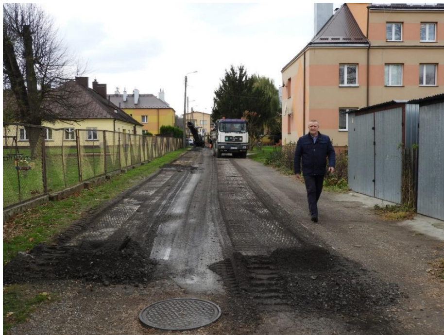
Droga na stadion podczas remontu.
