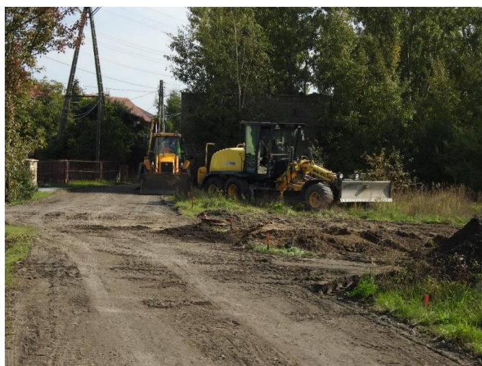
Remont drogi ul. Fabryczna.
