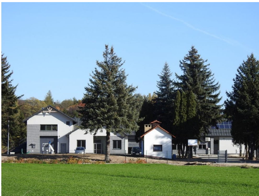
Widok na oczyszczalnię ścieków po zakończonej inwestycji.
