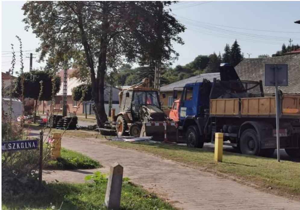
Remont drogi powiatowej nr 0656T w miejscowości Kunów, ul. Warszawska.
