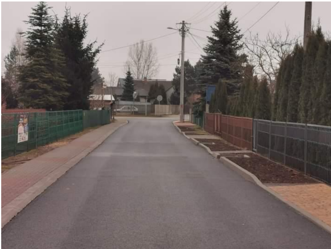
ul. Wesoła w Wymysłowie po remoncie.
