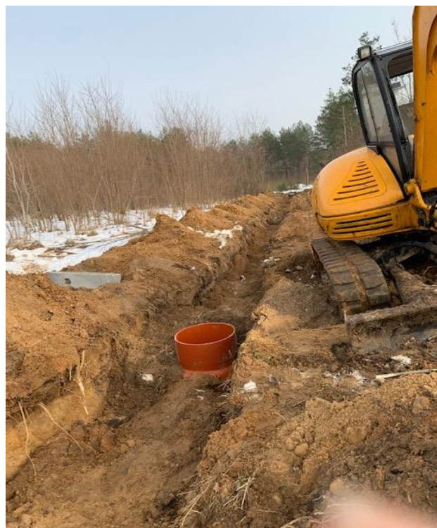
Budowa kanalizacji sanitarnej w miejscowości Janik, gmina Kunów.
