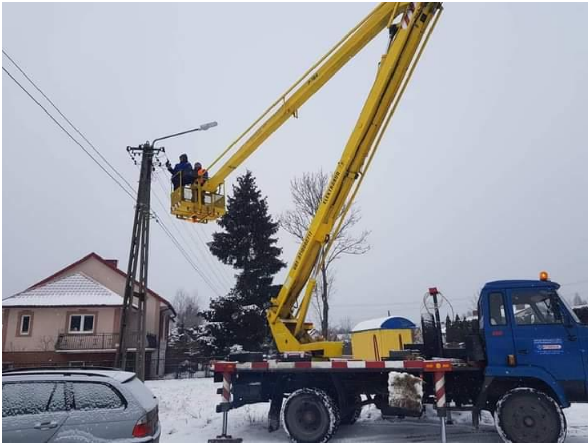
Prace przy modernizacji oświetlenia w gminie Kunów.
