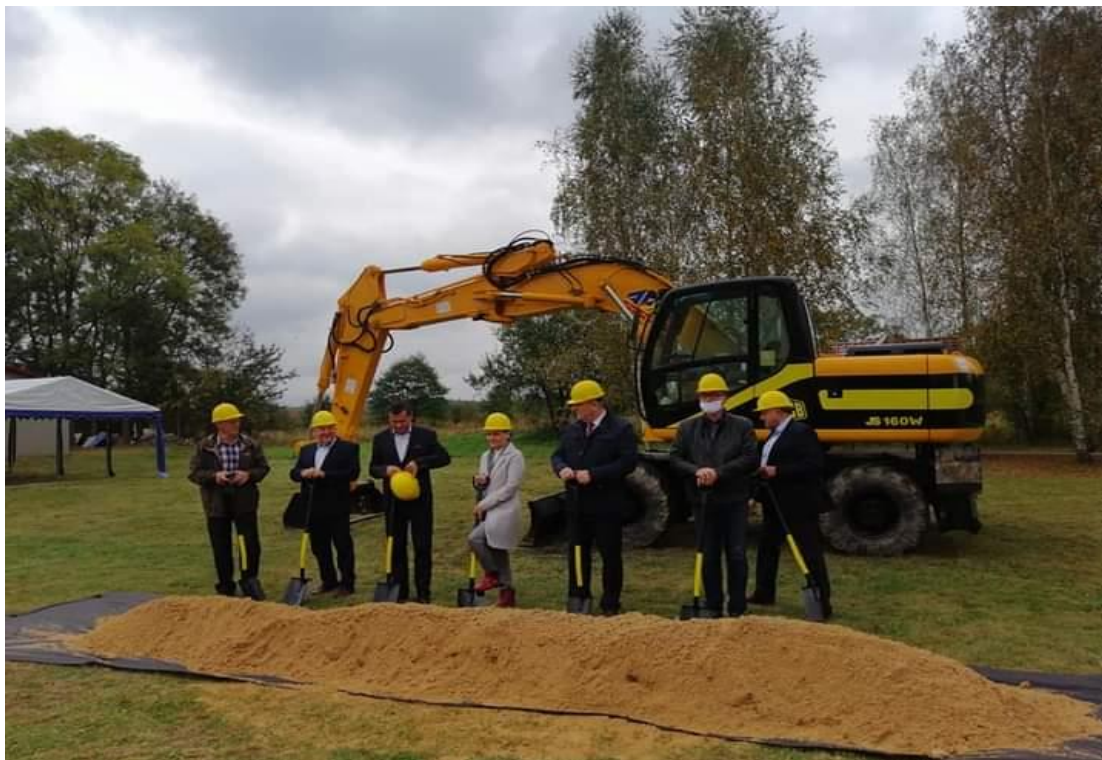
Symboliczne wbicie łopaty, rozpoczynające budowę kanalizacji sanitarnej w miejscowości Janik, gmina Kunów.
