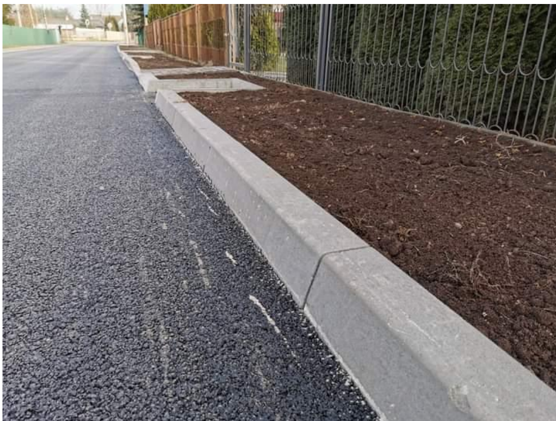
ul. Wesoła w Wymysłowie po remoncie.
