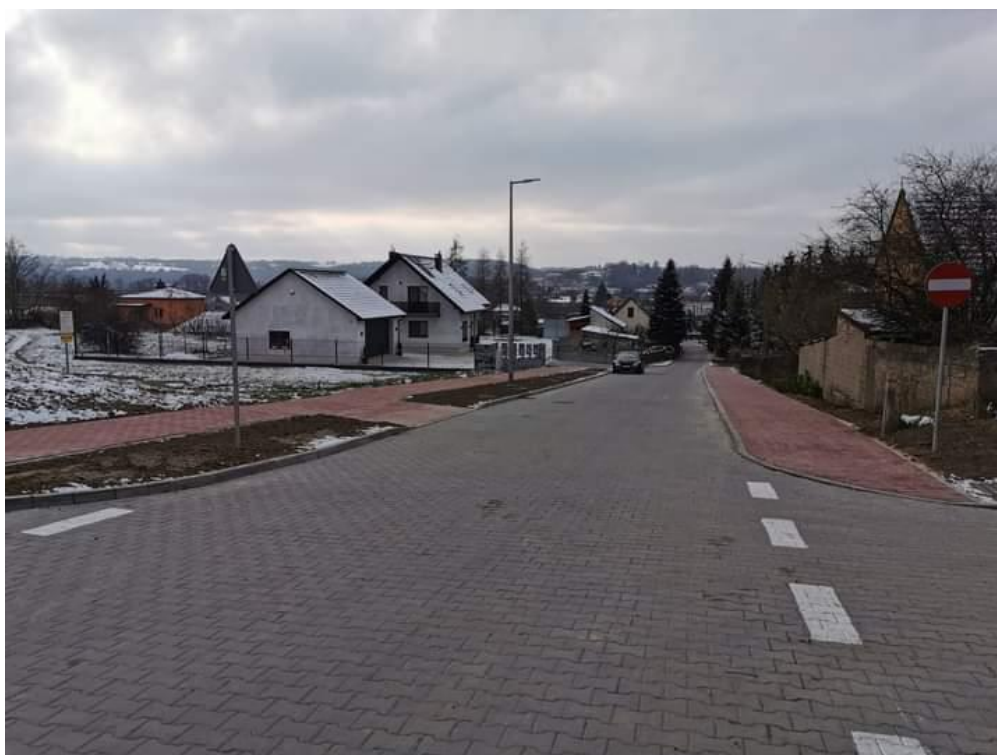
ul. Prosta w Kunowie po przebudowie i remoncie.
