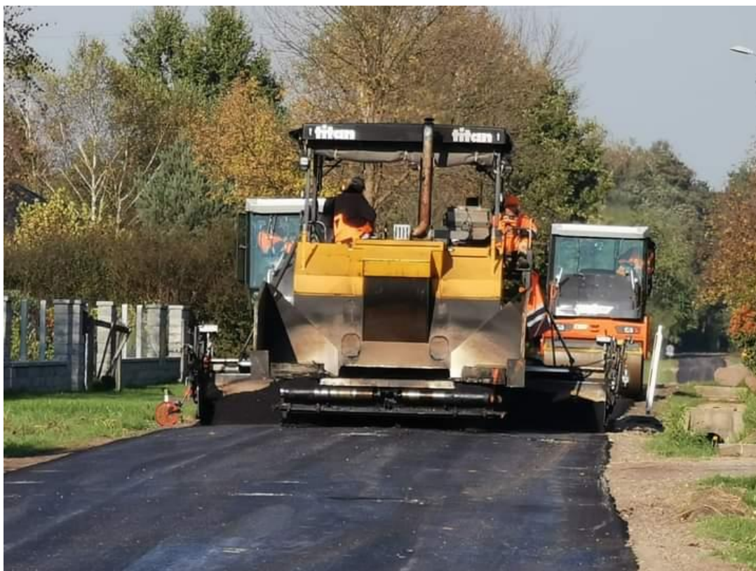
Remont drogi powiatowej „Kunów – Piaski – Janik” w miejscowości Janik.
