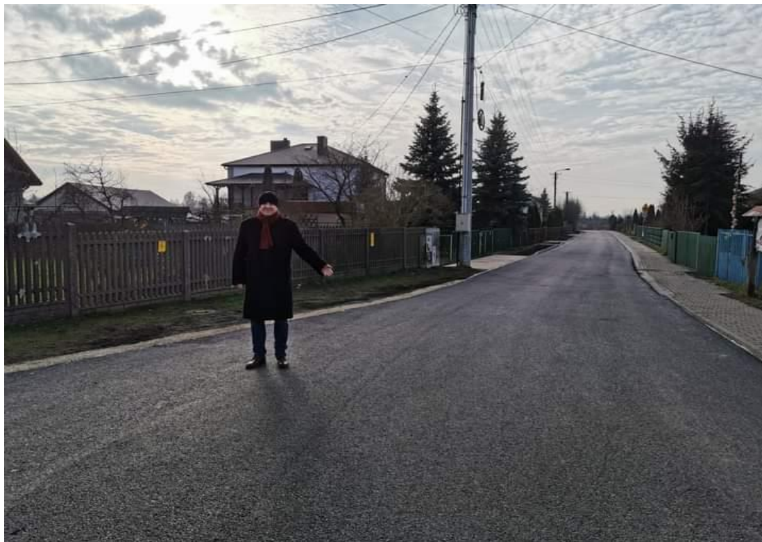
ul. Wesoła w Wymysłowie po remoncie.
