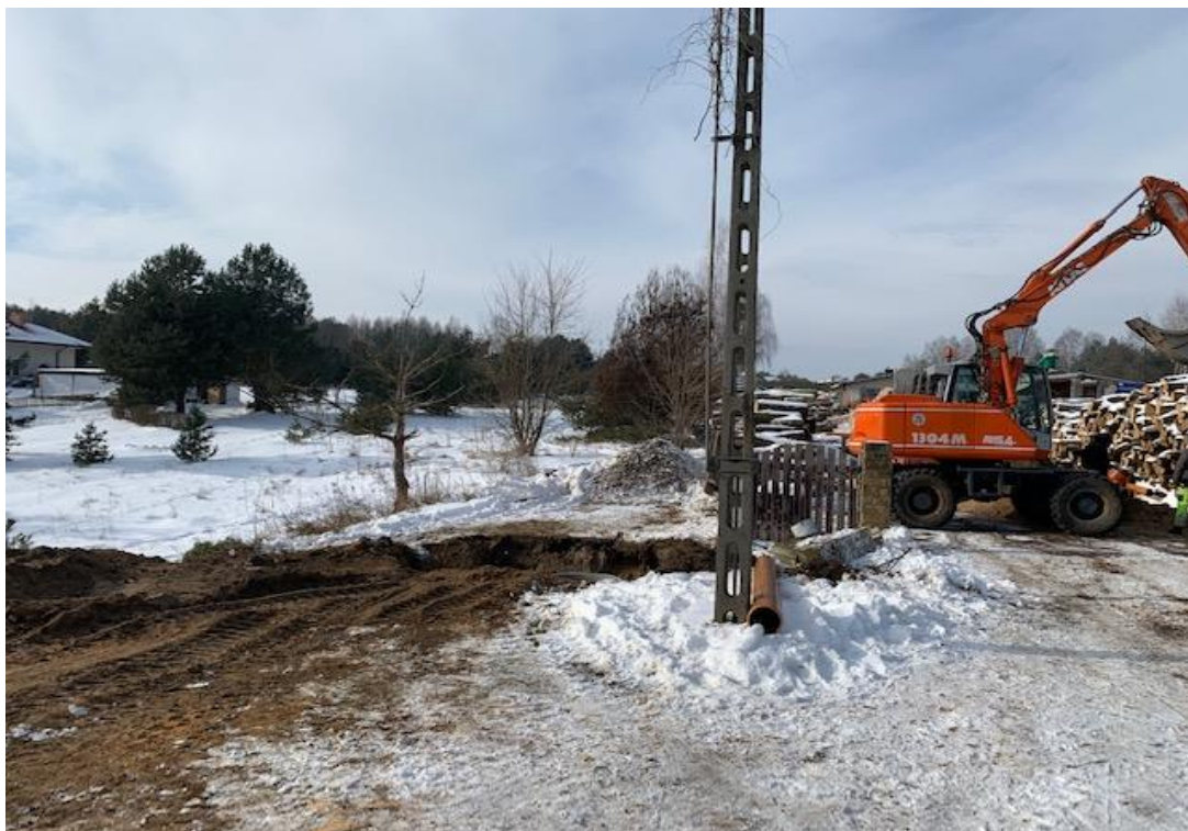
Budowa kanalizacji sanitarnej w miejscowości Janik, gmina Kunów.
