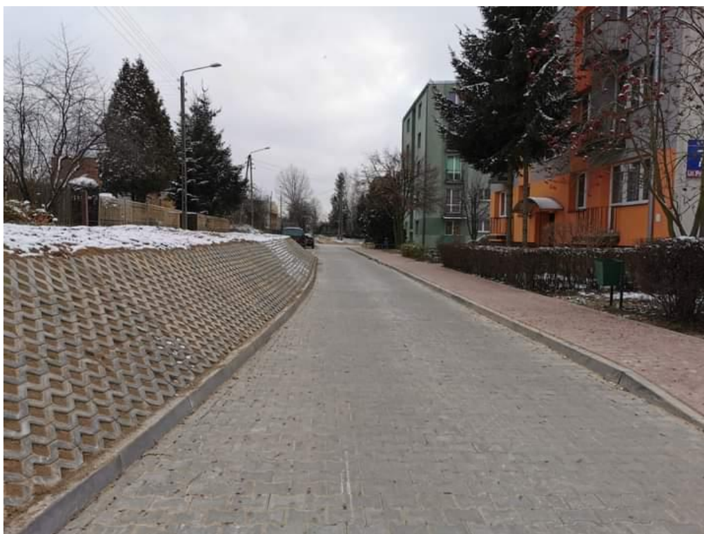
Drogi dojazdowa przy ul. Prostej tzw. „dyrektorówka” – po remoncie.
