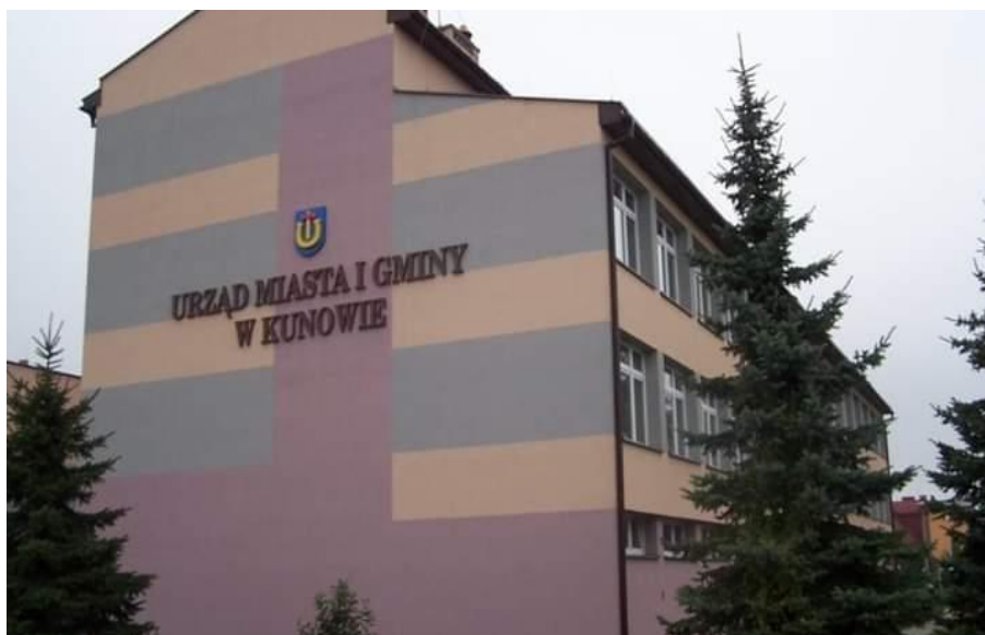
Budynek Urzędu Miasta i Gminy w Kunowie – przed termomodernizacją.
