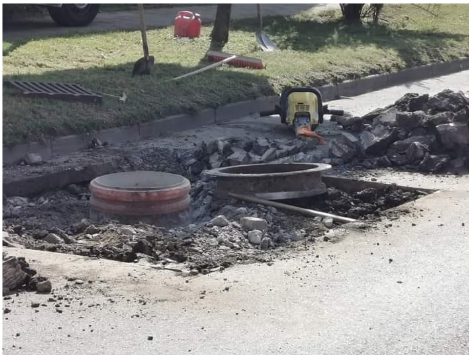
Remont drogi powiatowej w miejscowości Kunów, ul. Warszawska.
