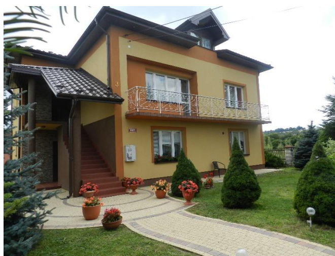
Zagroda w miejscowości Udziców I miejsce
